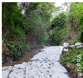
Protection d'une zone de travail avec des feuilles de sorbant
