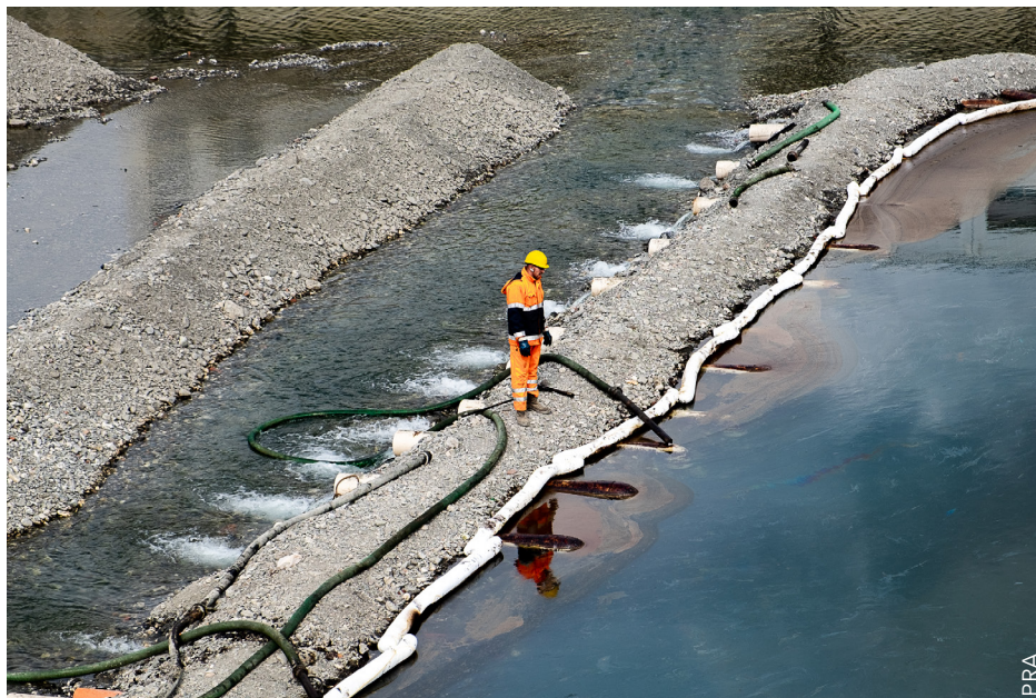
Remblai et tuyaux inclinés afin de filtrer la matière polluante flottante
