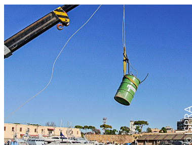
Hissage d'un fût à l'aide d'une grue
